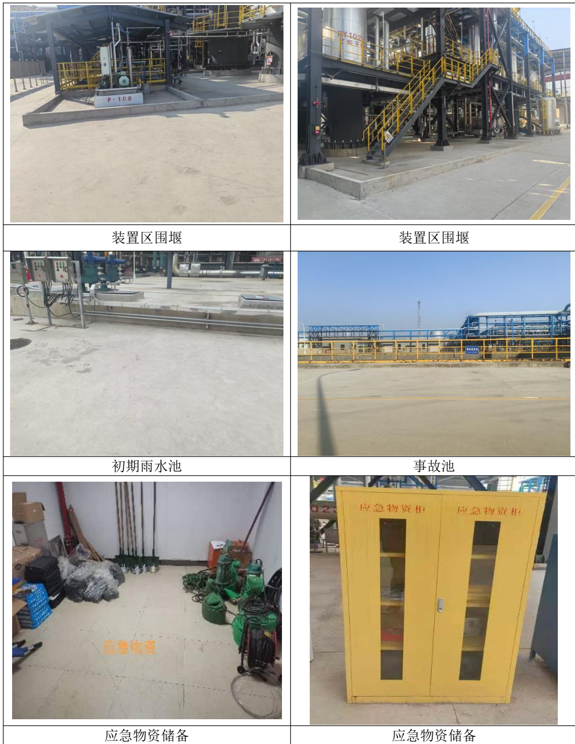
图 4.2-1 本项目应急响应相关设施设备
